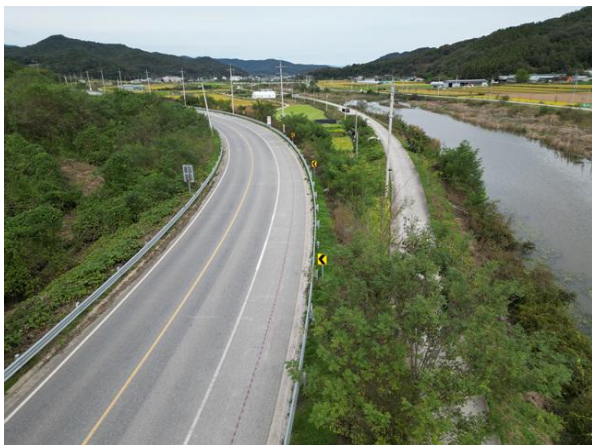
주변영향인자(성토부, 상부 본선) 상태현황
