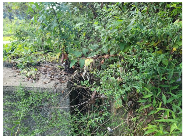
주변영향인자(성토부, 상부 본선) 상태현황
